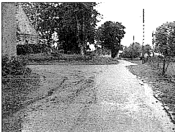
Droga gminna asfaltowa
