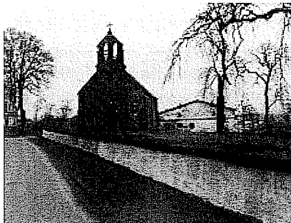
Otoczenie kościoła filialnego pw. Matki Boskiej Gromnicznej - aktualny stan techniczny.
