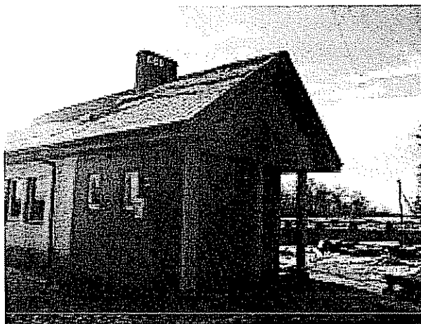
Stan istniejący świetlicy wiejskiej – widok z zewnątrz
