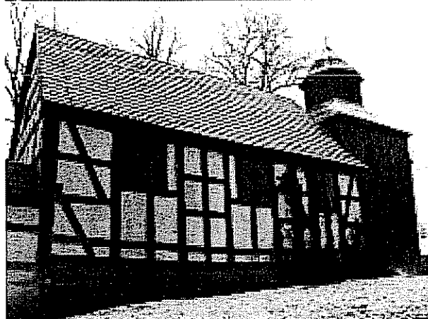
Widok na zabytkową świątynię w Gardnie - aktualny stan techniczny.
